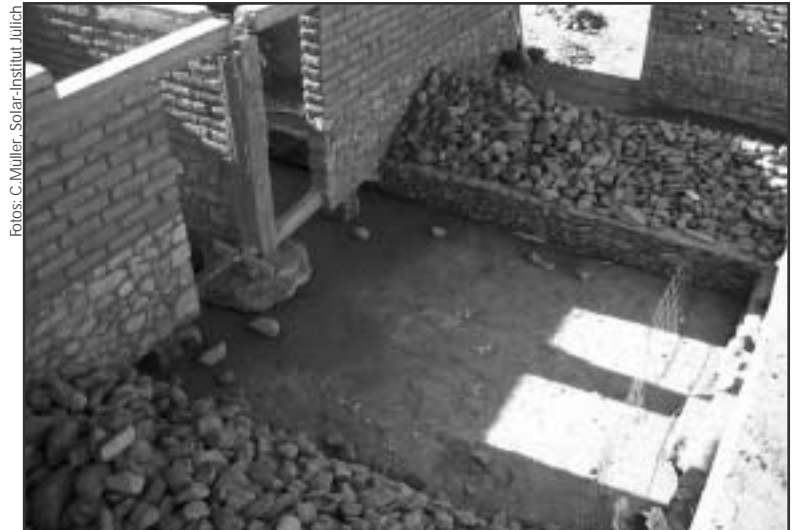
Kiesbett-Wärmespeicher vor der Beladung, Argentinien
