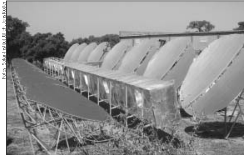
Spiegelpark der Solarbäckerei in Ouagadougou
